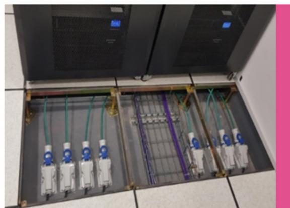
La canalización eléctrica será instalada bajo piso técnico utilizando canastillo porta conductor para el fácil acceso y manipulación del cableado.
